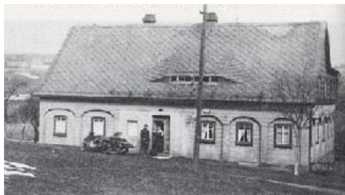
Dům č.p. 66, na kterém byla původně věžička se zvonem
