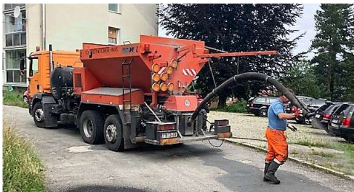
Oprava komunikace na sídlišti
